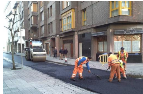
Figura 3. Labores manuales de acabado en el asfaltado.
