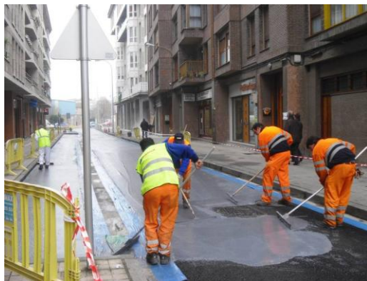
Figura 5. Aplicación del Noxer.
