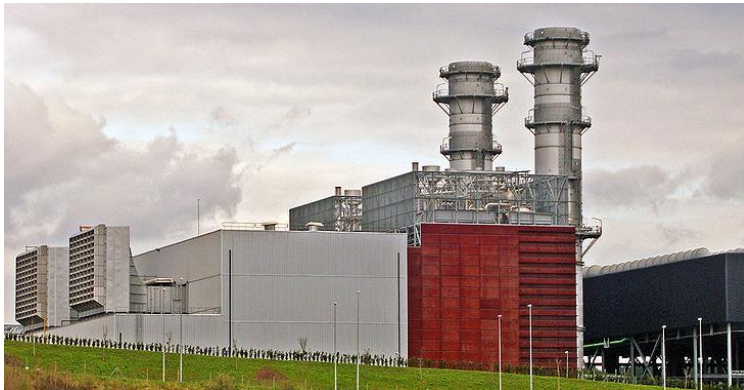
Figura 2. Central térmica de ciclo combinado de Boroa.
