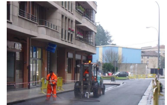
Figura 4. Limpieza con agua a presión.
